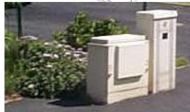
à éviter : coffrets non intégrés
