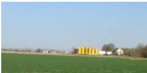
Ci-dessus, à éviter : L'alternance répétée de couleurs sur de grandes surfaces de bâtiments agricoles ou industriels les rend très visibles dans un paysage.
