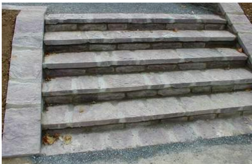
Escalier en dalles de schiste
