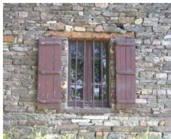
Ouvertures simples présentent sur les bâtiments agricoles avec linteaux en bois et jambages en pierres
