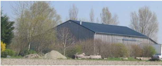
Intégration d'un bâtiment par un bardage bois et des plantations
