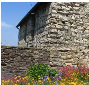
Appareillage mixte de plaquettes de schiste et de moellons de grès
