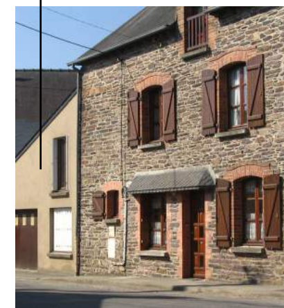
Enduit proche de la couleur du grès
