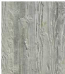
Béton banché avec empreinte du bois ayant servi au coffrage
