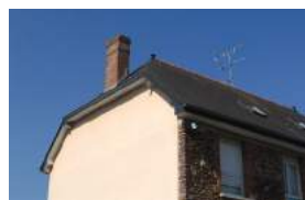
Exemple de toiture en demi-croupe
