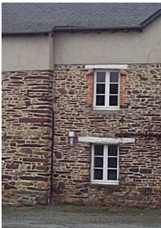
Traitement de l'angle par des plaquettes de schiste
