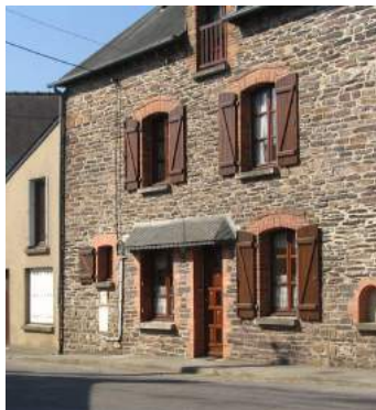
Les jambages en briques sont les plus fréquents sur les maisons de caractère plus noble, les moellons en granit sont parfois utilisés.
