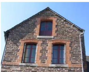
Appareillage de briques (jambages et arcs de décharge) fréquent en centre bourg
