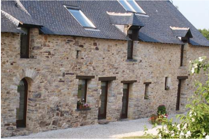
Exemple de réhabilitation ayant préservé les ouvertures d'origine
