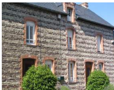
Appareillage alterné de schiste et de grès formant des bandes bicolores.
