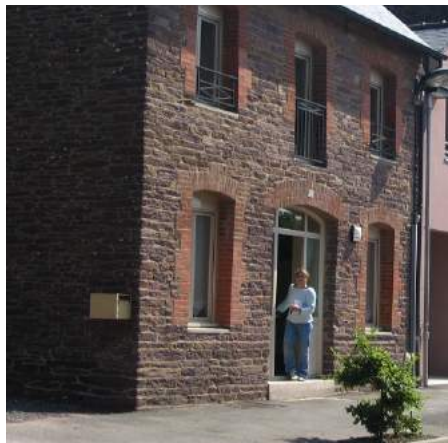
Appareillage de moellons de schiste
